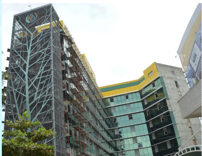
Le bâtiment annexe R+8 en attente de livraison
